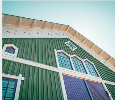
^ Bygger traditionella trähus med modern teknik.
